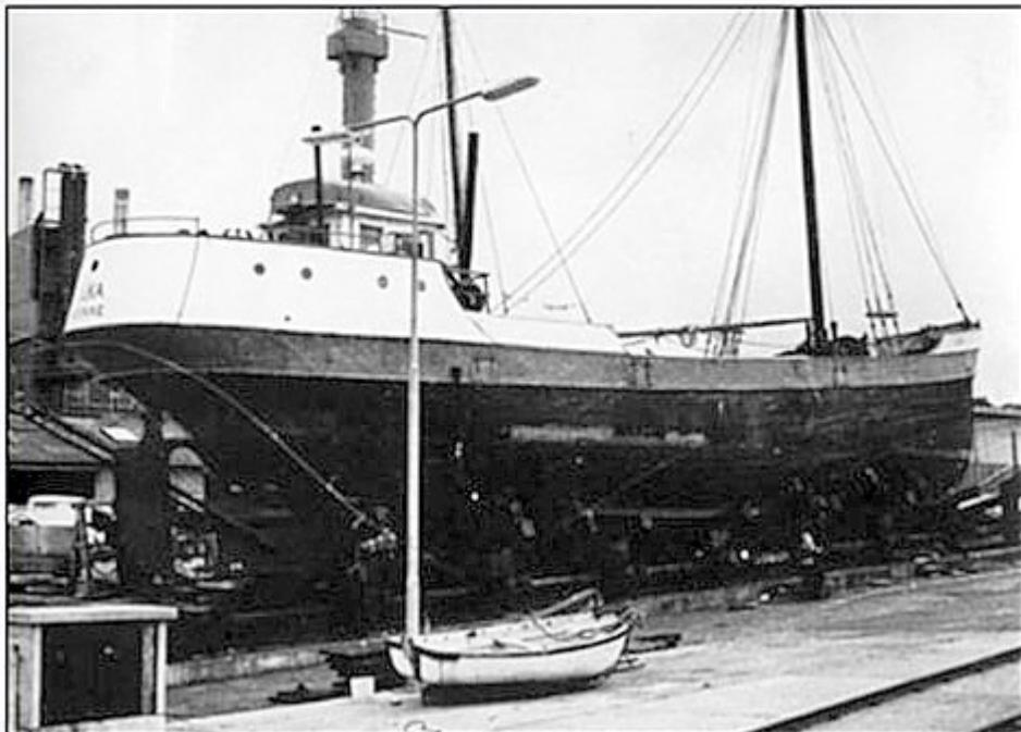
S/S Havörnen på varv i Rönne på Bornholm. Fartyget är omdöpt och förmodligen försedd med modernare maskineri.
