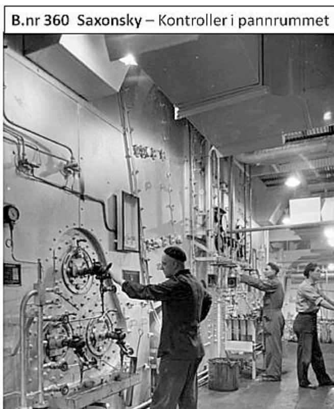
B.nr 360 Saxonsky – Kontroller i pannrummet.
